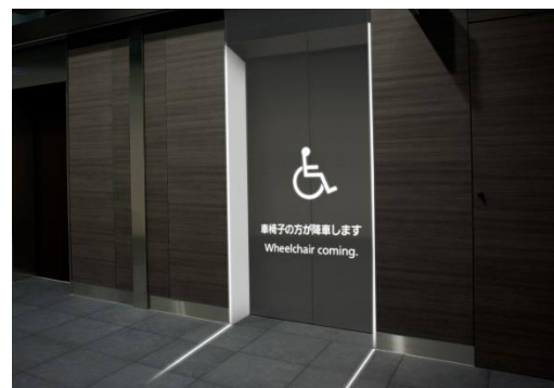
Orientación proyectada sobre la puerta del ascensor
