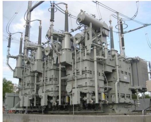
Transformador trifásico dividido especial
