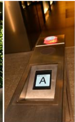
Indicador LCD de la puerta de seguridad que muestra el ascensor asignado al usuario
