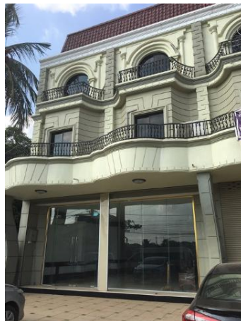
Edificio donde se ubicará MLAO
