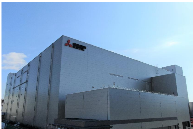
Nueva instalación en la fábrica Kamakura Works
