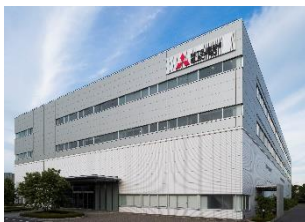
Planta Industrial Mechatronics Systems Works (en las instalaciones de Nagoya Works)
