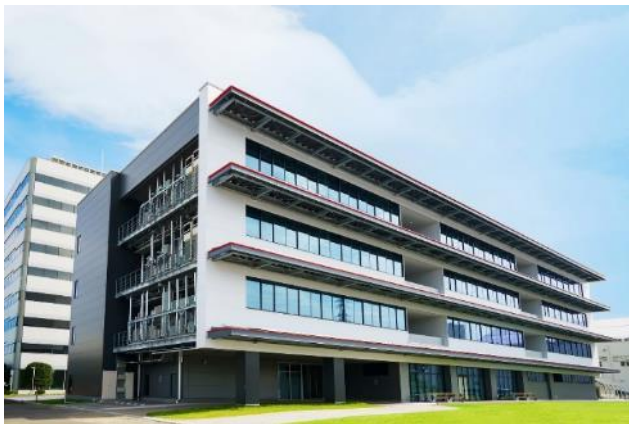
Centro de pruebas de energía neta cero "SUSTIE"
